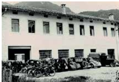
Zgradba Avtoservisa Gorenšček, ki jo je postavil Albert Gorenšček leta 1929, je bila tiste čase daleč največja mehanična in ličarska delavnica na Primorskem, ob njej so v sklopu servisa postavili tudi bencinsko črpalko Shell.
