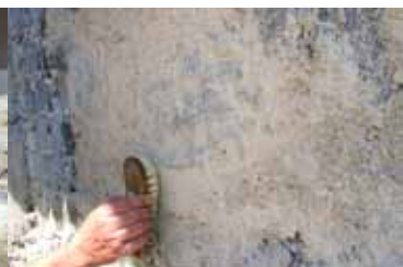
Proces začetnega nanašanja apnenega ometa.
