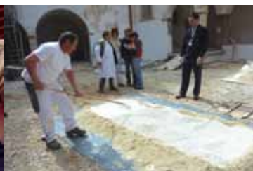
Prikaz klasične metode priprave apnene malte.
