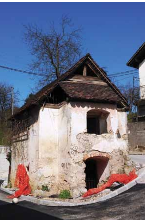
Stara kašča pred obnovo.
