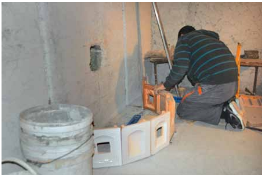
Na Dnevu poklicev so bodoči pečarji prikazali postavitev kmečke peči.
