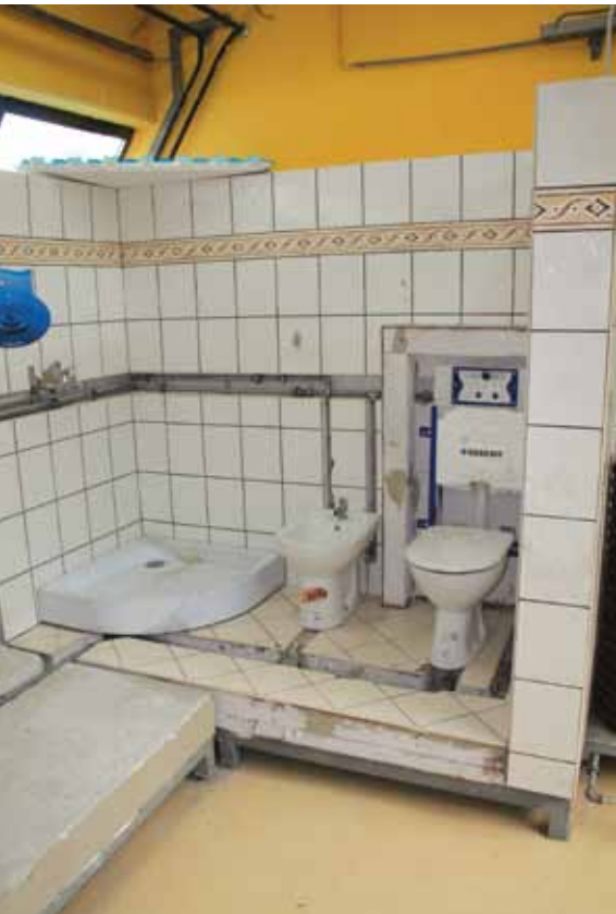
Učna postaja, maketa razvoda vodovoda in odtokov, kjer se inštalaterji učijo pravil montaže vodovodnih sistemov.
