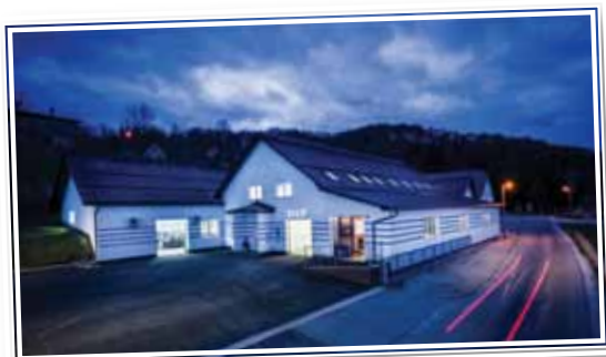
Poslovna stavba podjetja ELED.
