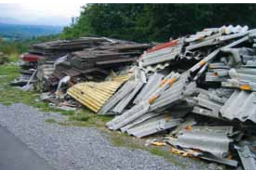
Varno odlaganje azbestnih izdelkov je pomemben del vsakega načrta za odstranjevanje nevarne kritine.
