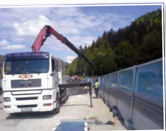
Postavljanje protihrupne ograje na novem nadvozu nad železniško progo v Zgornjem Logu.
