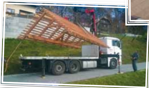
Simon Lokar s sodelavci je izdelal novo streho za vaško sušilnico sadja.
