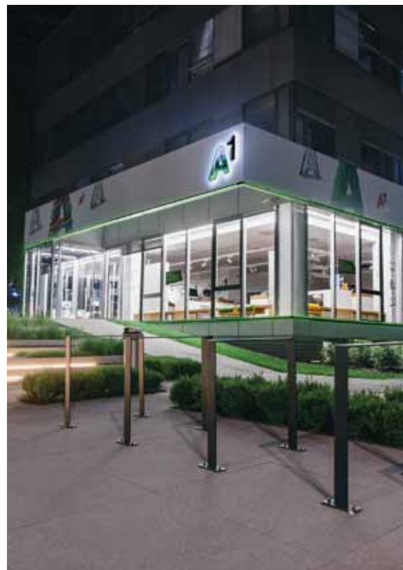
Reklamni napisi na poslovni zgradbi uprave A1 v Ljubljani.
