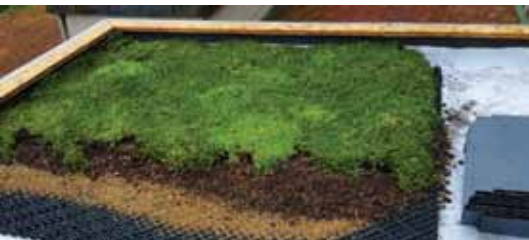
Za izvedbo ravnih streh in teras pa je ZKG prejelo podjetje Hipox.
