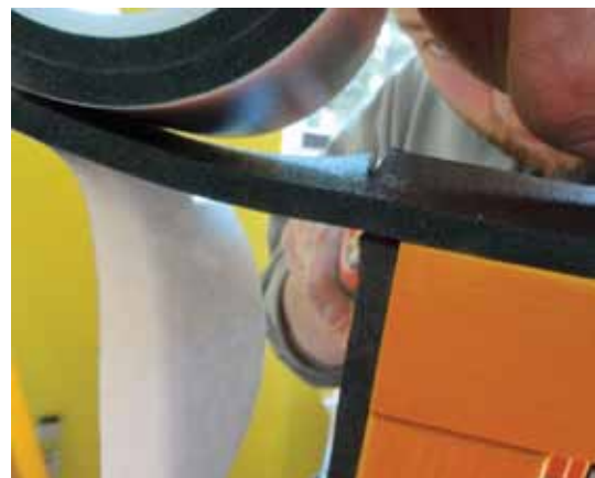
Podjetje Jelovica je prejela ZKG za sodobno vgradnjo zunanjega stavbnega pohištva.
