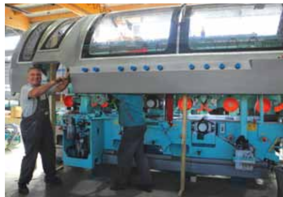
V novi razvojno-proizvodni hali že montirajo Multiplan, stroj za štiristransko skobljanje. Izdelan je za tovarno lepljenih plošč na Norveškem.
