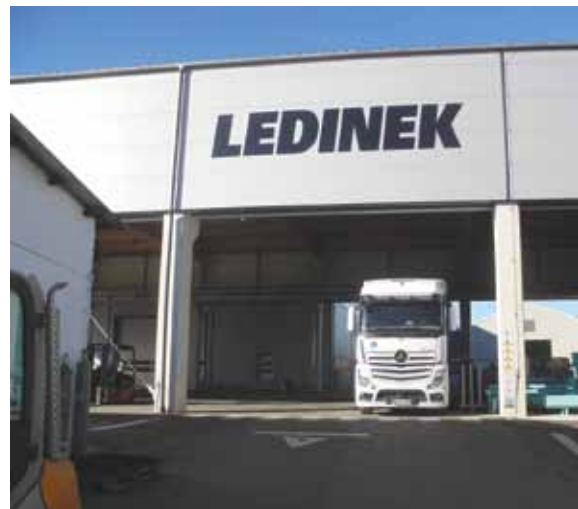
V podjetju Lestro Ledinek so konec minulega meseca v Hočah odprli nov sodoben razvojno-proizvodni objekt. Pravzaprav dva nova objekta: nadstrešnico, ki povezuje stari in novi montažni del, namenjeno nalaganju strojev na tovarnjak, ter novo montažno halo, ki ima v podaljšku poslovni del v treh nadstropjih.
