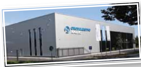
Novi poslovno-proizvodni prostori v Naklem.
