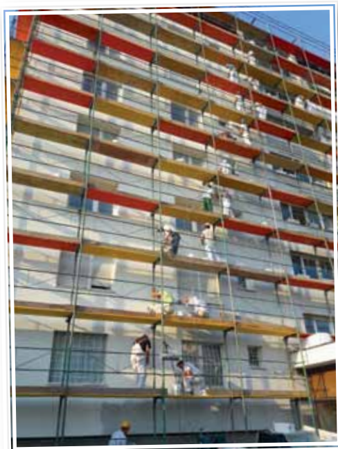
Izvajanje gradbenih del podjetja Proslík na terenu.
