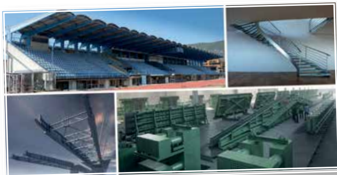
Streha nad tribunami atletskega stadiona v Novi Gorici. Primer arhitekturno zahtevnejšega stopnišča. Narivni nos za gradnjo avtocestnih viaduktov. Kalupi za prefabrikacijo betona.
