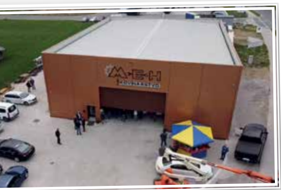
Kovinarstvo Meh ima v Poslovni coni Ozare Slovenj Gradec novo, sodobno in prostorno proizvodno halo.
