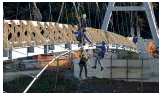
Dela na višini pri montaži najdaljše viseče brvi v Sloveniji v Solkanu.
