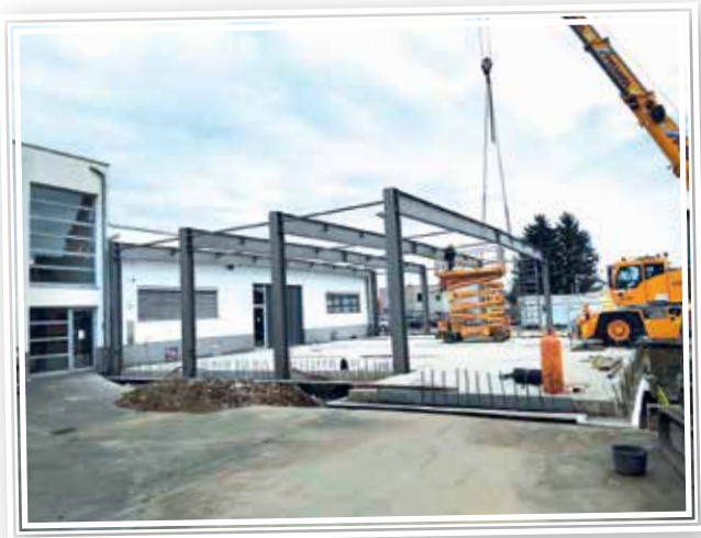
Montaža kovinske konstrukcije.
